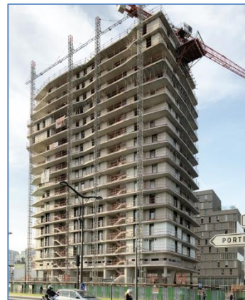
Chantier de la tour M6B2
