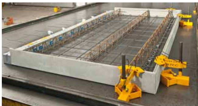
Réalisation d'un balcon préfabriqué avec Schöck ASE DW1, intégrant les rupteurs de balcons Schöck Rutherma®.
