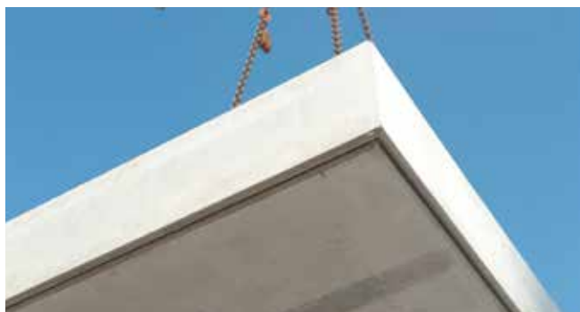
Focus sur la goutte d'eau du Schöck ASE DW1 en sous face du balcon.
